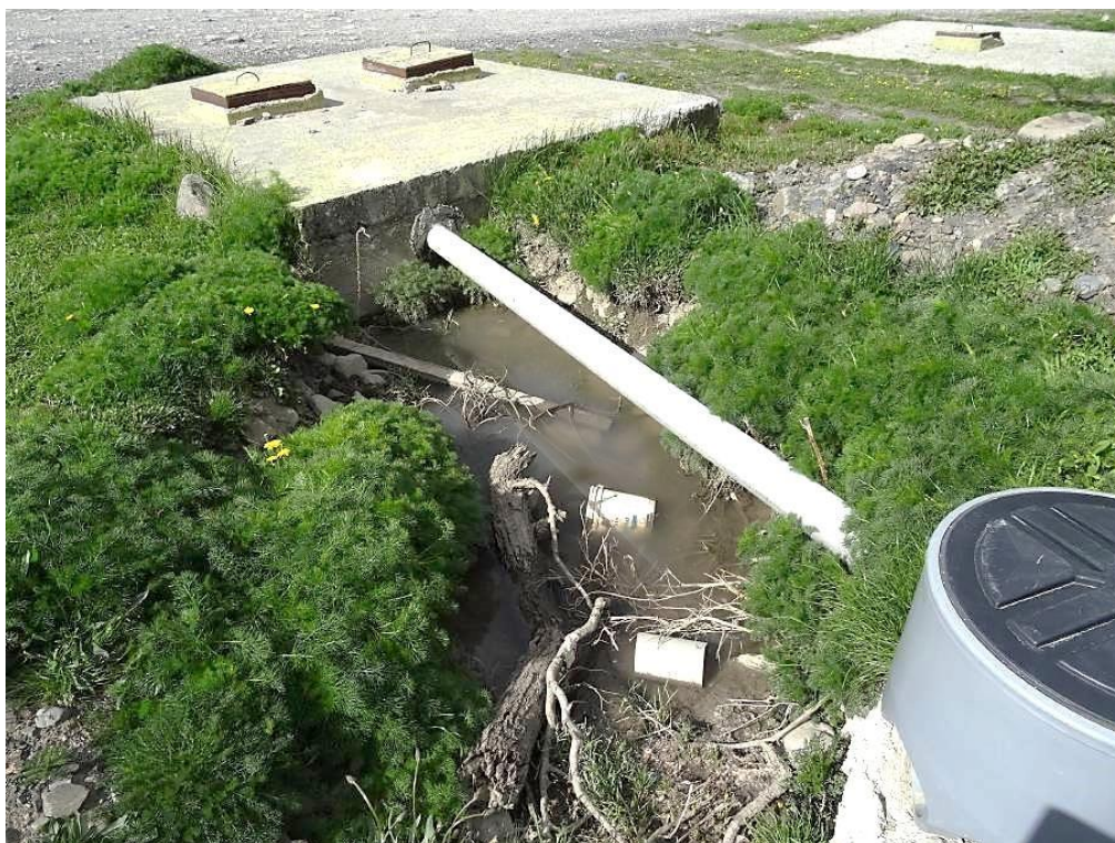
Imagen N° 2: Detalle Zona de filtración en fosa séptica, Informe SMA
